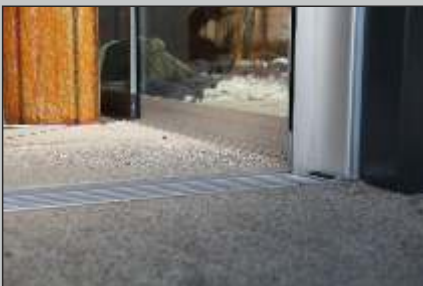
Detail Bodenschiene versenkt
