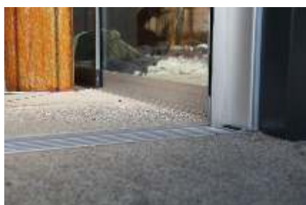
Detail Bodenschiene versenkt
